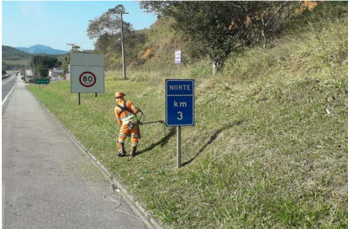
Figura 6.7 Via Lagos - Roçada Manual - Km 3+000 Norte
