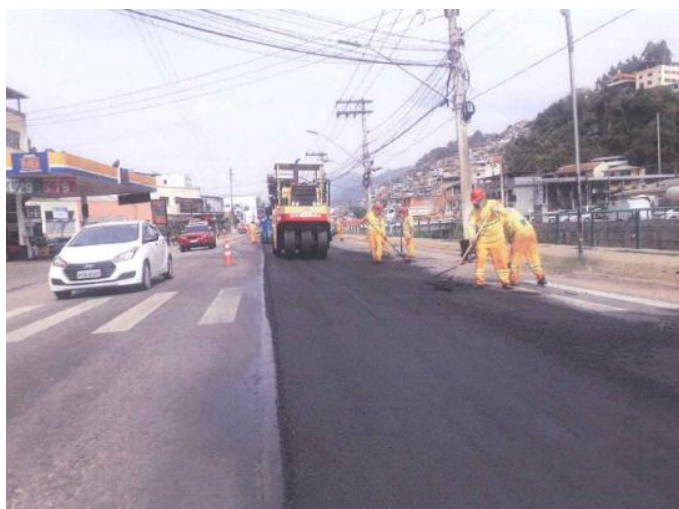
Figura 6.17 Rota 116 – Reparos de pavimento – km 85 ao 87
