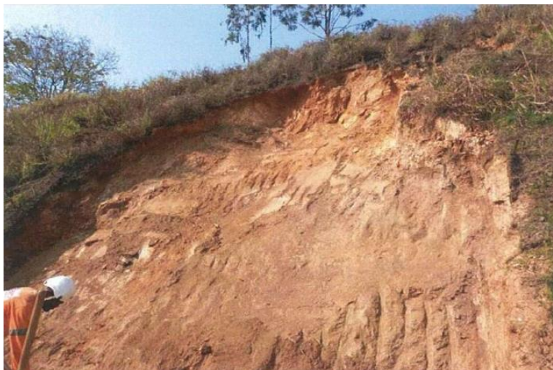
Figura 6.16 Via Lagos - Talude de Corte - Km 7+300 Norte
