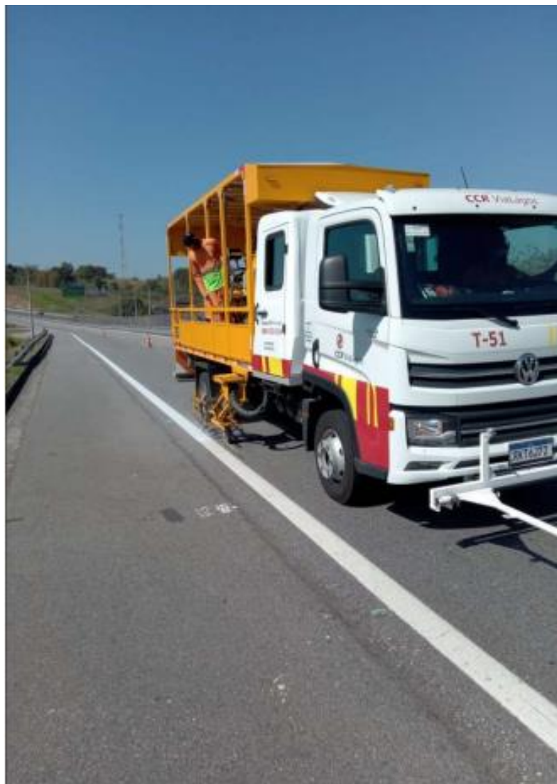
Figura 6.2 Via Lagos – Pintura de faixas – Km 40+500 Sul
