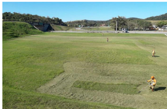
Figura 6.9 Via Lagos - Roçada Manual - Km 21+500 Sul
