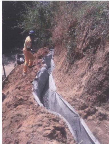
Figura 6.13 Rota 116 – Implantação Drenagem – Km 62
