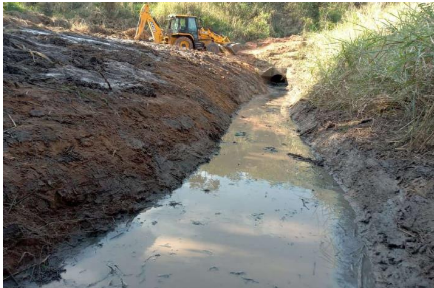
Figura 4.5 Via Lagos - Limpeza de Bueiro - Km 29+540 Norte
