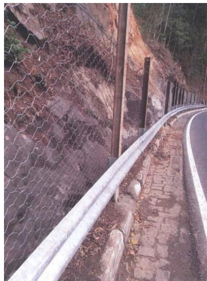
Figura 6.15 Rota 116 – Contenção de Encosta – Implantação de tela de proteção – km 74
