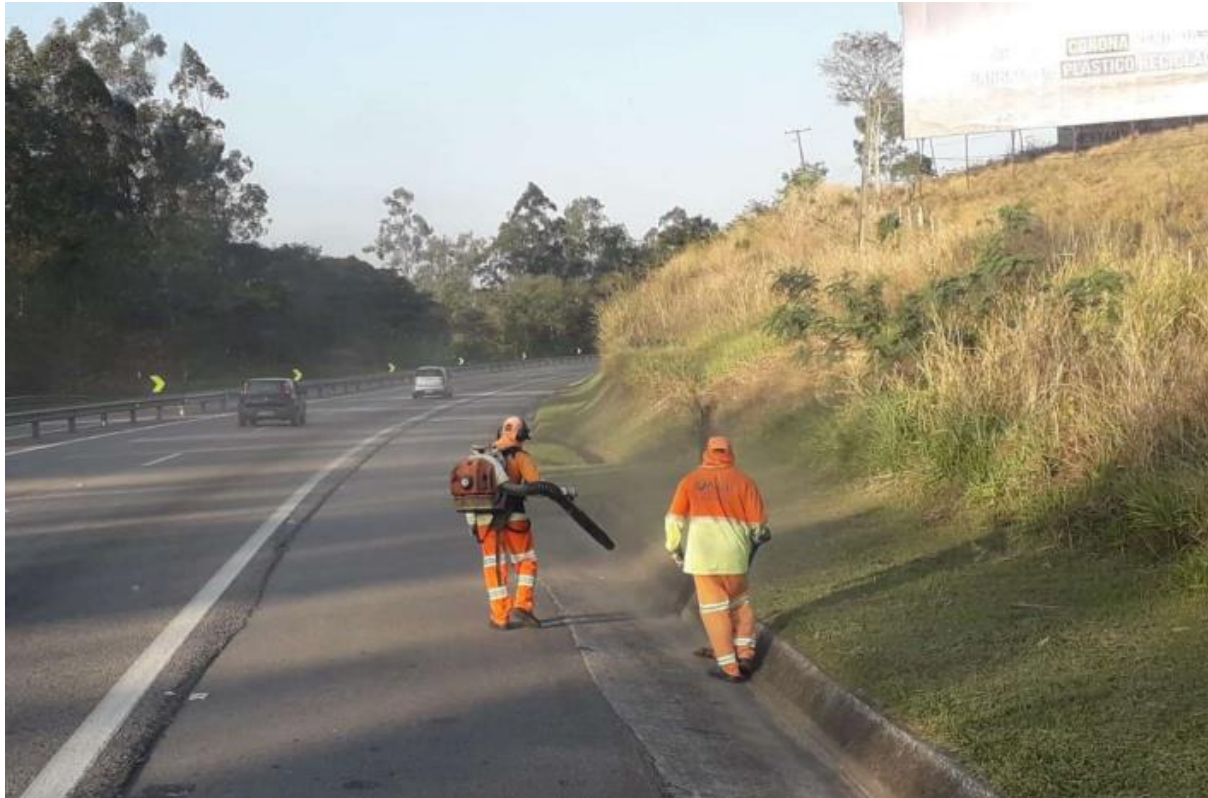
Figura 6.8 Via Lagos - Roçada Manual - Km 18+500 Norte
