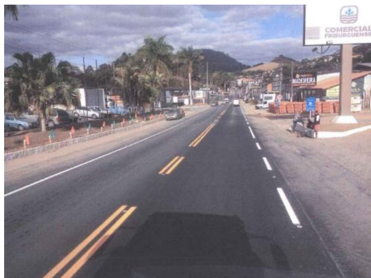
Figura 6.5 Rota 116 – Reparos de pavimento – km 99.5 ao 102
