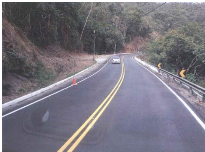
Figura 6.16 Rota 116 – Reparos de pavimento – km 73 ao 74.2
